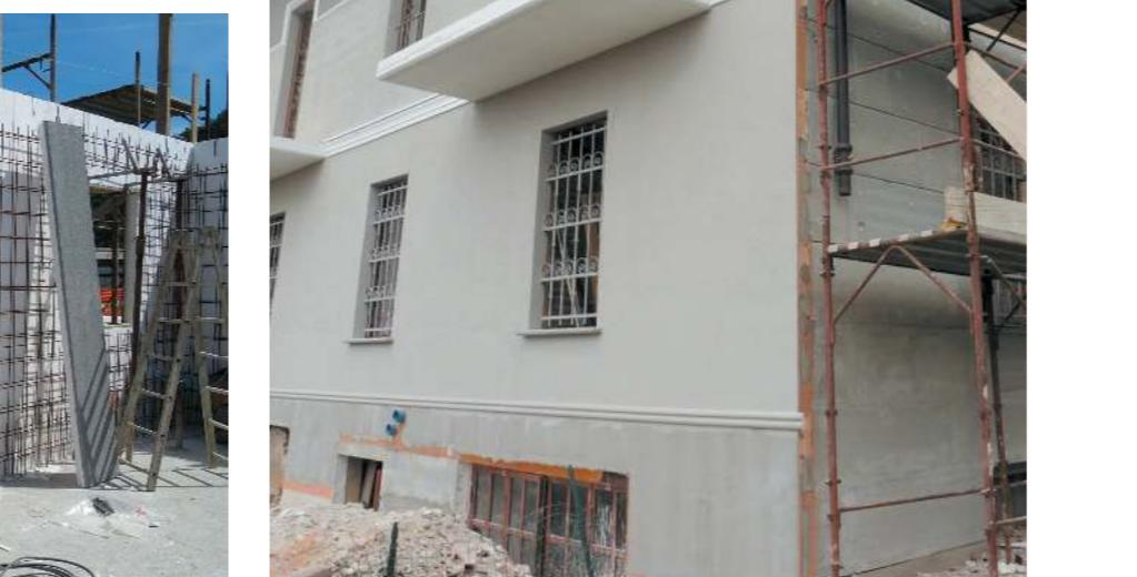
Componenti e caratteristiche del sistema Vertema3: pannello costituito da uno strato isolante in polistirene espanso di spessore variabile, armato con rete eletrosaldata sagomata e getto in C.L.S. alleggerito con palline in P.S.E., facile da tagliare, scanalare, ecc. e adattabile a qualsiasi tipologia progettuale.
